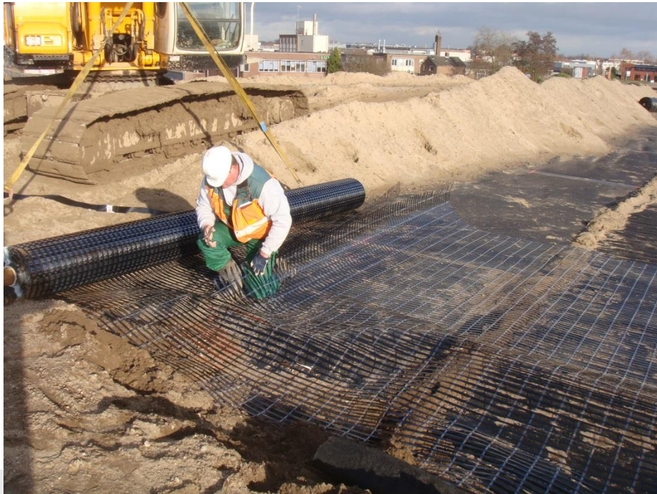
Foto: Bij 8.2 en 8.3: Aanbrengen geogrids.
