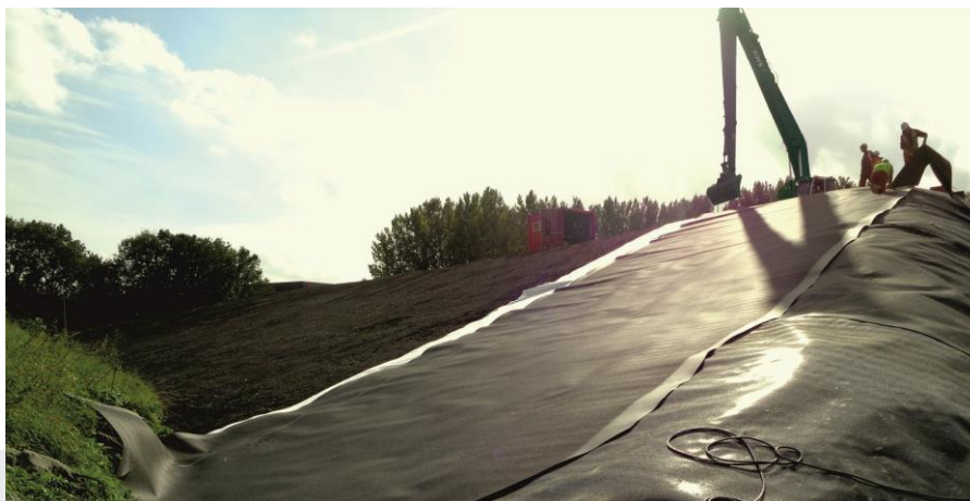
Foto: Overzicht aanleg IBC-werk.
