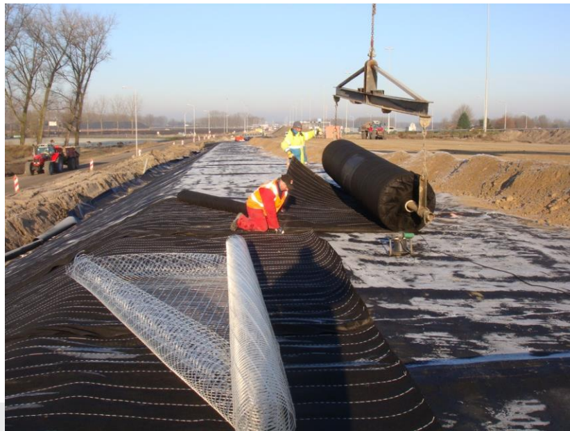
Foto: Bij 11: Aanbrengen drainagemat en geogrids.
