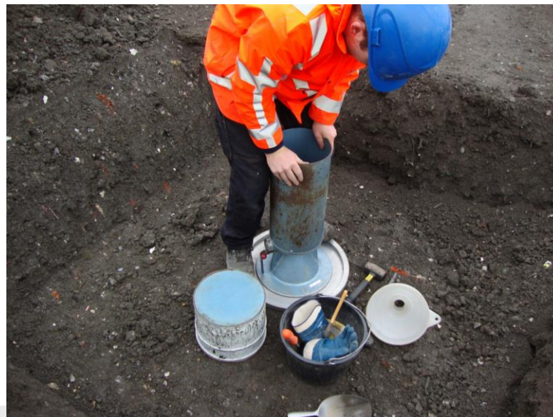
Foto: Bij 4.2 en 4.3: Meting verdichting AEC bodemas en bepalen verdichtingsgraad.
