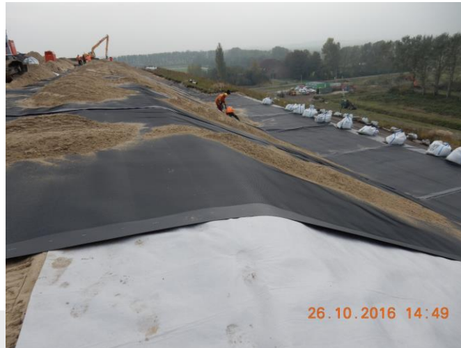
Foto: Aanbrengen geotextiel en HDPE-folie.
