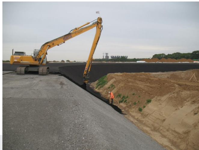
Foto: Aanleg van zandbentonietpolymeergel.
